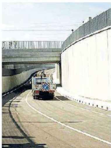
Il sottopasso di via Manetti
